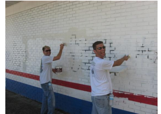
Wiping out graffiti in Orlando!
